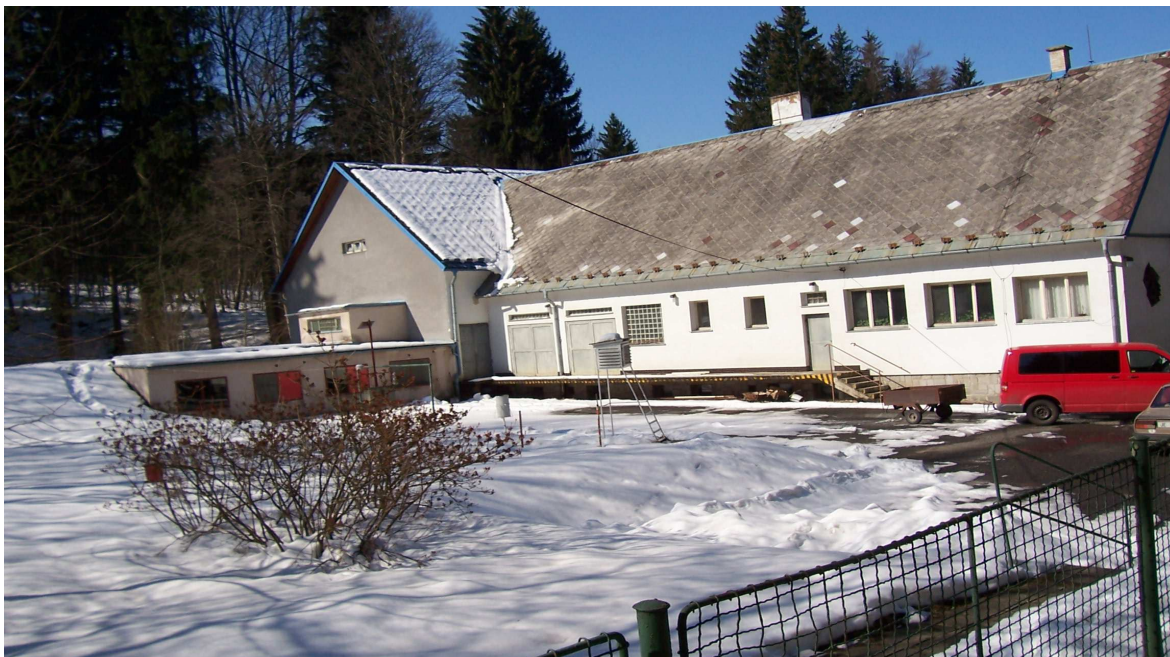
Pohled na Úpravnu vody v Adolfovicích
