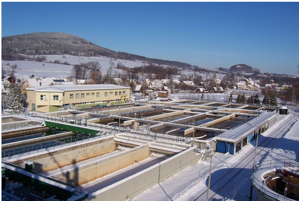
Pohled na ČOV Česká Ves v lednu 2007
