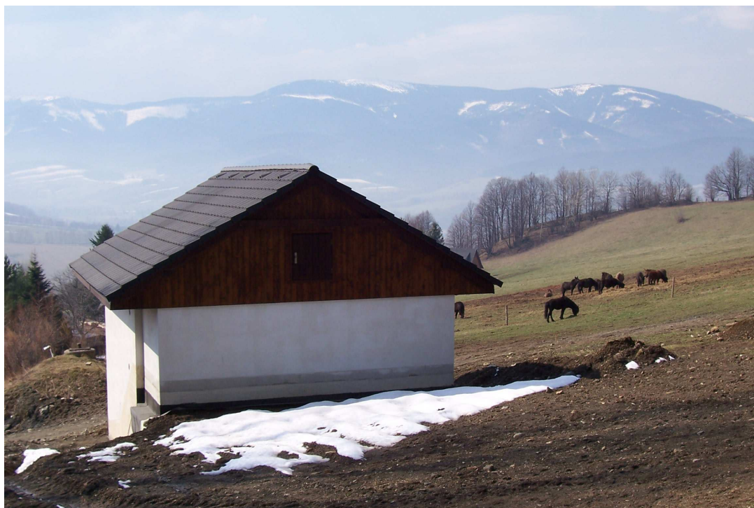
Nový vodojem 2 x 50 m 3 Seč
