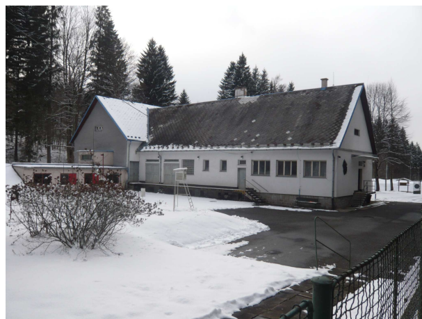
Pohled na Úpravnu vody v Adolfovicích
