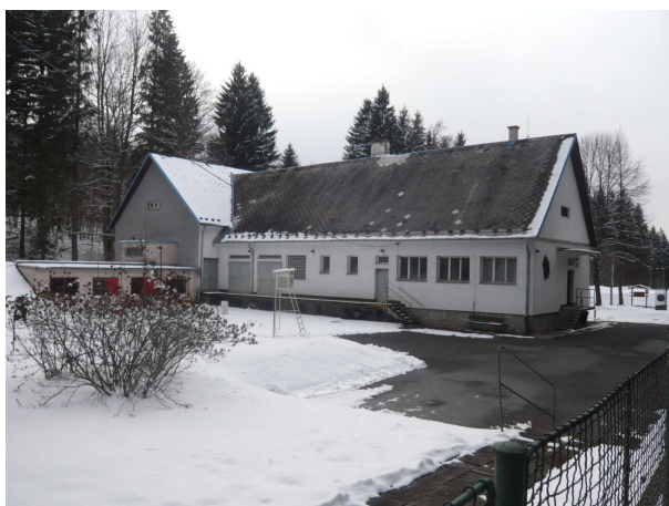
Pohled na Úpravnu vody v Adolfovicích
