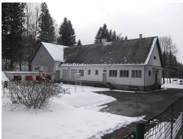
Pohled na Úpravnu vody v Adolfovicích
