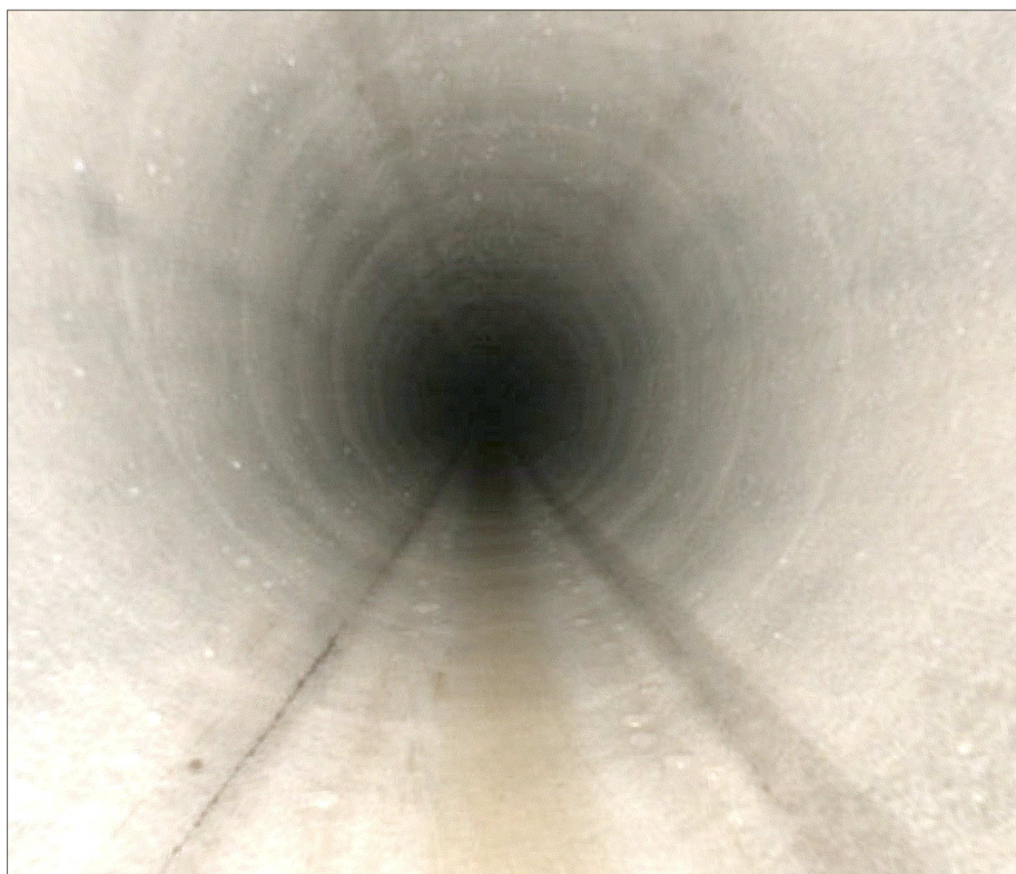
Konečné provedení vložky – vytvrzený rukávec uvnitř kanalizační stoky, foto z kamerové inspekce uložené a vytvrzené vložky
