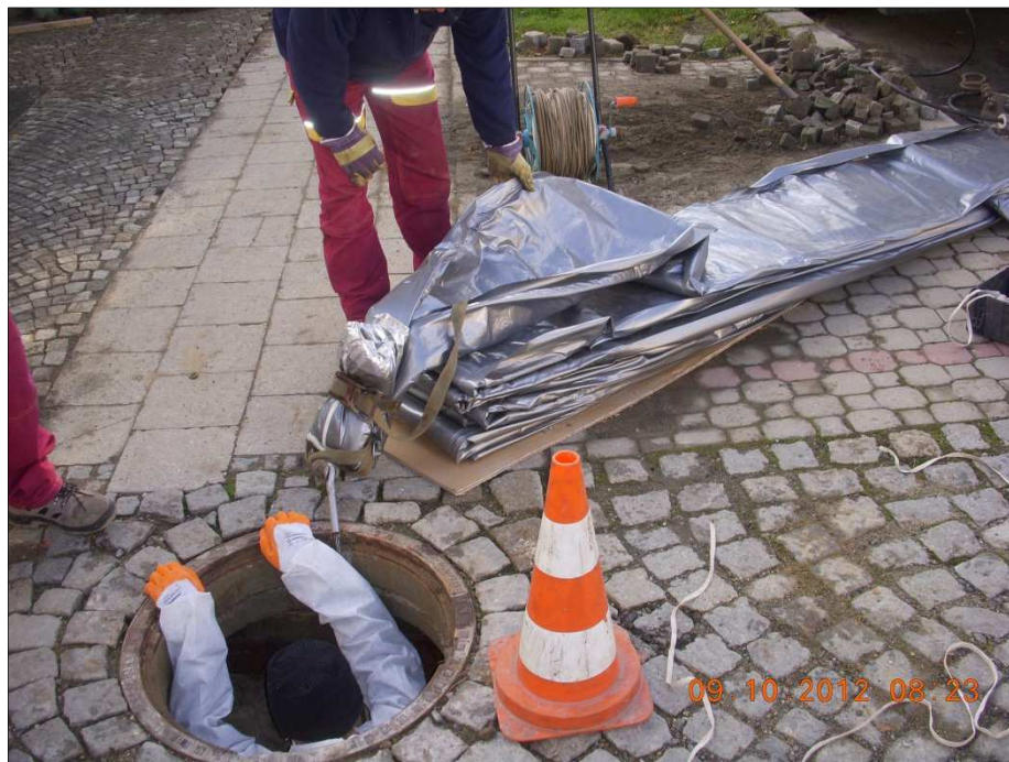
Příprava na zatažení rukávce – vložky do kanalizační stoky
