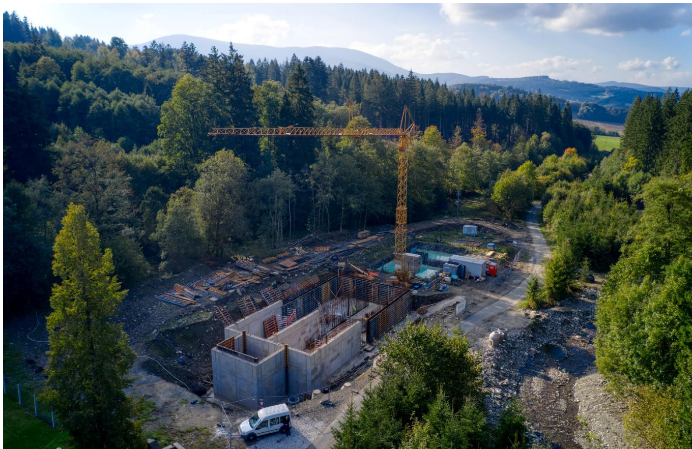
Výstavba nového vodojemu 1000 m 3 - NOVÝ VZ KEPRNICKÝ POTOK A PŘÍVÁDĚCÍ ŘAD PRO ÚV ADOLFOVICE (foto: Tomáš Neuwirth)
