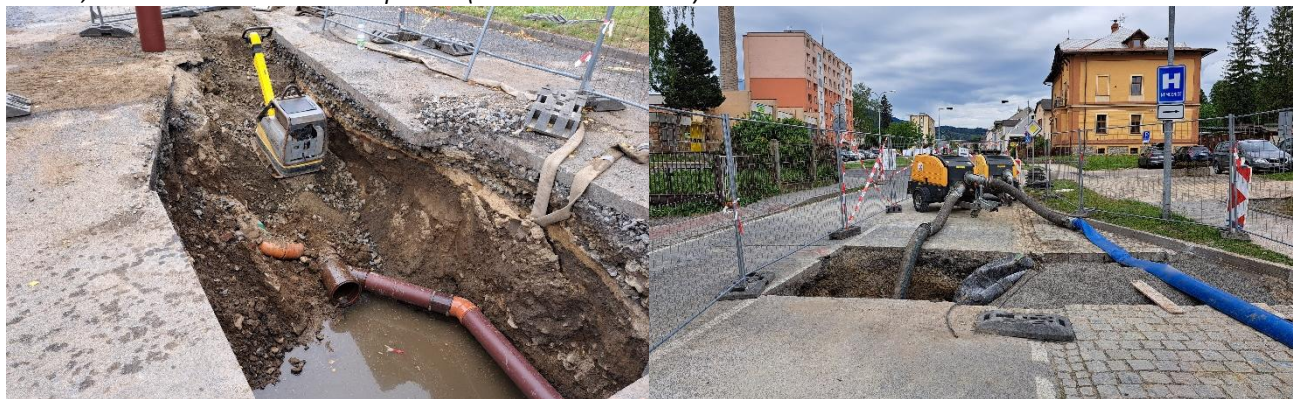
Jeseník, obnova kanalizace v ulici Lipovská (realizace 2023-2024)
