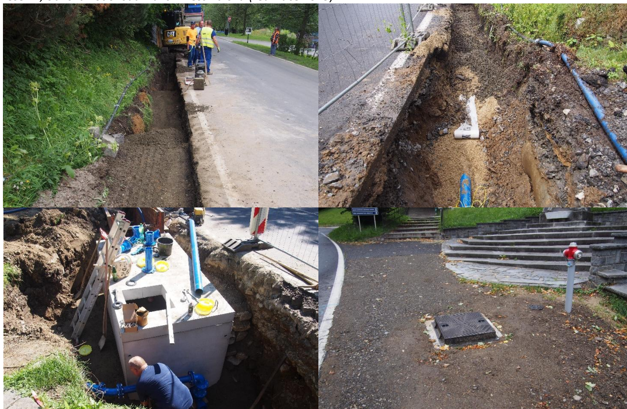
Jeseník, obnova vodovodu v ulici Priessnitzova (realizace 2023)
