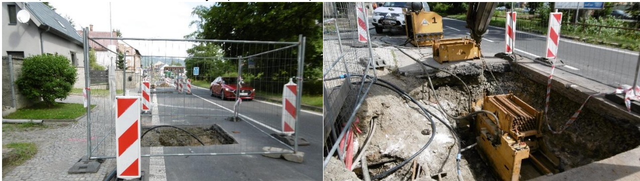
Lipová-lázně, obnova vodovodu v lokalitě "K Nádraží" (realizace 2022-2023)
